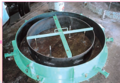
鋼板リングを型枠にセット
