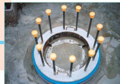
PCリング設置完了
