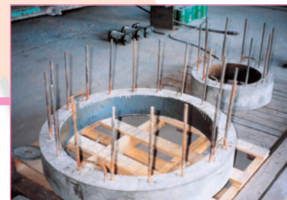
型枠脱型後
