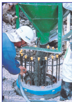
⑦ 中詰コンクリート打設
