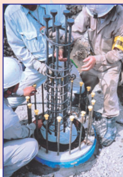
⑤ 鉄筋カゴのセット
