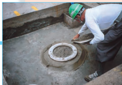
杭頭にモルタルを敷く
