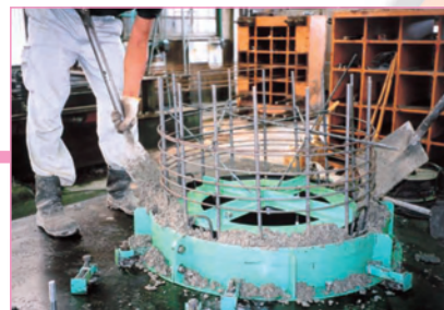
コンクリート打設状況
