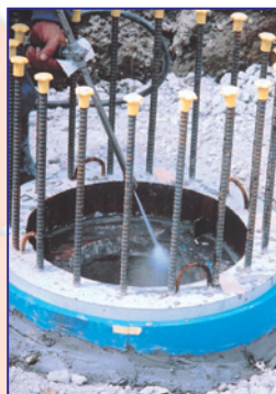
② 杭内面の洗浄
