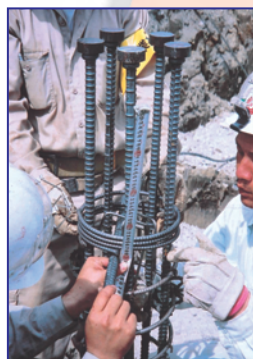
④ 鉄筋カゴの組立て
