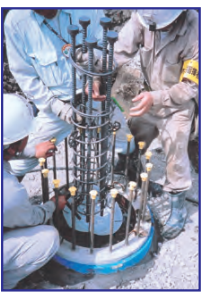
⑤ 鉄筋カゴのセット
