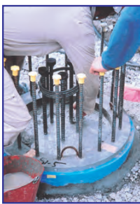
⑧ 中詰コンクリートを所定のレベルまで打設
