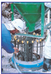
⑦ 中詰コンクリート打設
