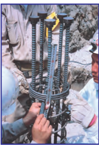
④ 鉄筋カゴの組立て
