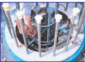
⑥ 鉄筋カゴはかんざし筋にて支持
