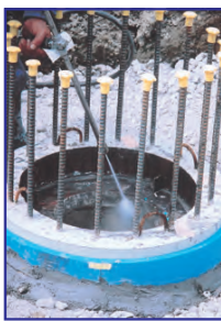
② 杭内面の洗浄
